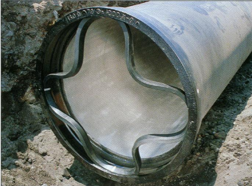
Lắp đặt gioăng cao su
